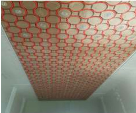
Bild 1: Lehmdecke vor Oberflächenbeschichtung
