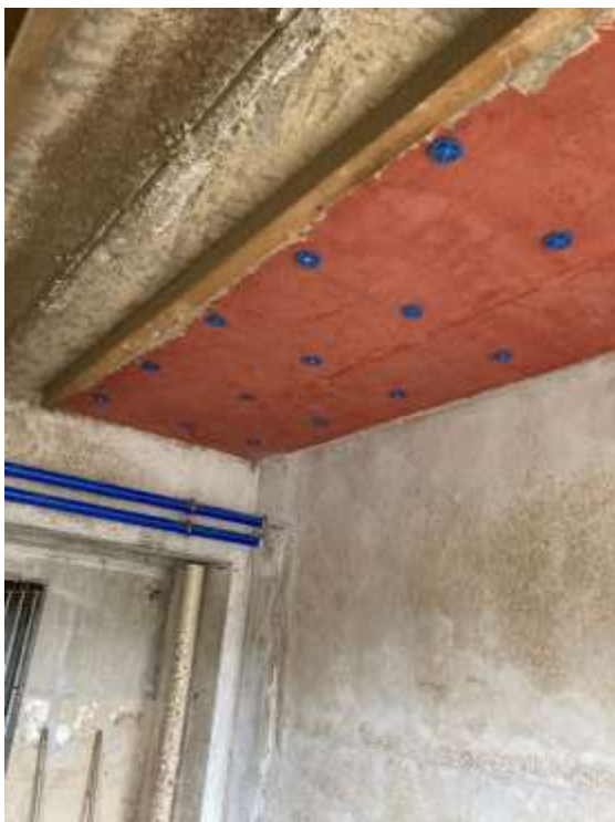
Bild 3: mit PutzPins befestigt
